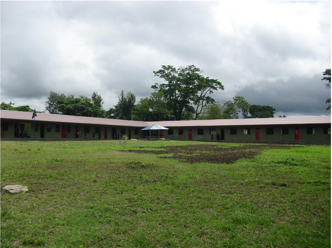
Blick auf die Räume für die 1te bis 7te Klasse.
